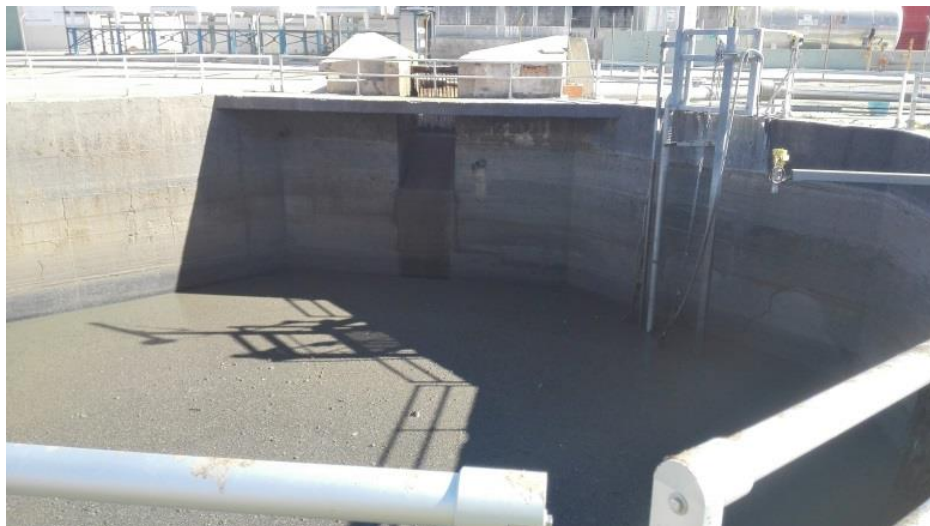
Figura 7. Balsa de almacenamiento de purines.
